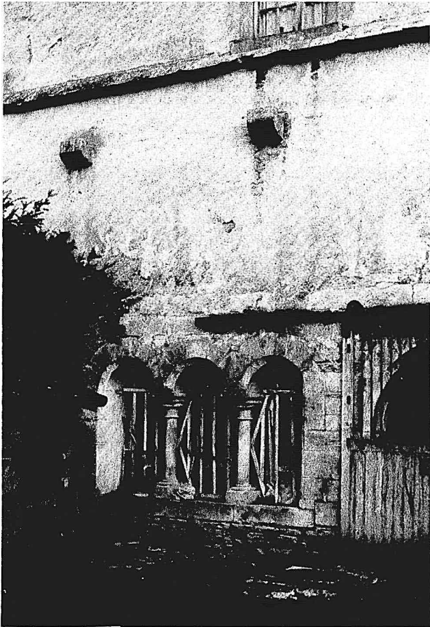
FIG. 4. — Bâtiment conventuel. Façade ouest. Corbeaux de la charpente du cloître et baies de la salle capitulaire.
