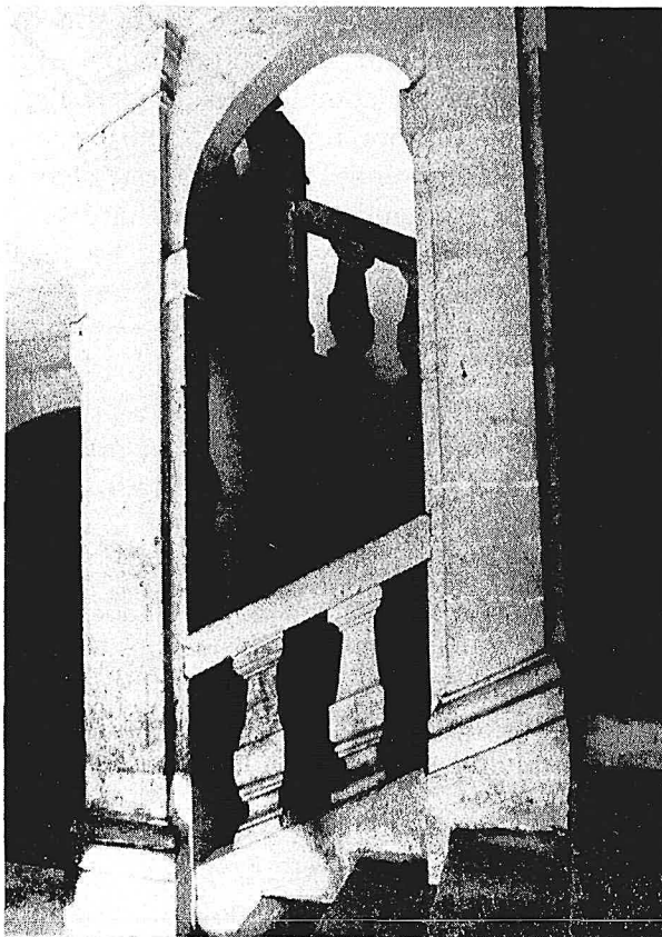
FIG. 8. — Escalier (xvii e siècle) à quatre noyaux.
